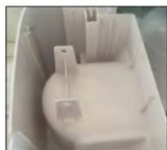
Ahora puede acceder al interior del depósito de agua
